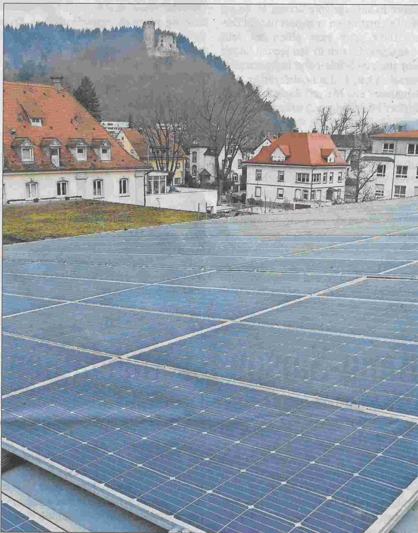
Es ist vollbracht: Die neue Photovoltaikanlage auf der Stadthalle Waldkirch ist am Netz.
