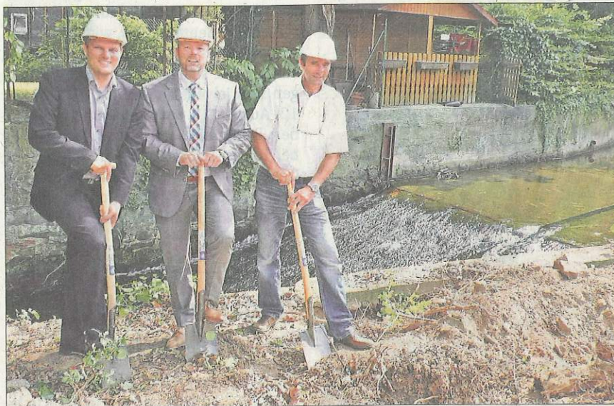
Oberbürgermeister Roman Götzmann, Stadtwerke-Geschäftsführer Thorsten Ruprecht und sein Mitarbeiter Andreas Spieles beim ersten offiziellen Spatenstich für Waldkirchs neues Wasserkraftwerk. FOTO: SREDNIAWA
